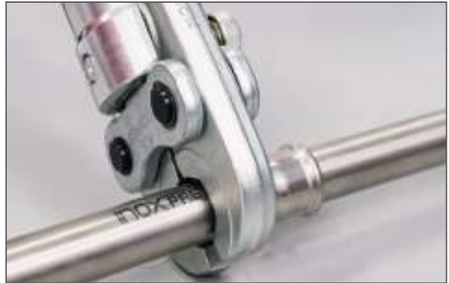
Assemblaggio attraverso pressatura / Making the press connection
